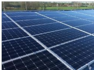
Deutschland Abbau Anlage 577 kWp
