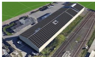
Niedersachsen voraussichtlich 296 kWp
