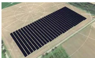
Bayern voraussichtlich 8.327 kWp
