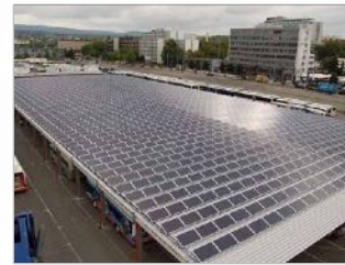
Deutschland Abbau Anlage 405 kWp
