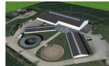
Schleswig-Holstein voraussichtlich 264 kWp
