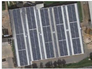
Deutschland Dachanlage in Betrieb 929 kWp
