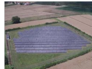
Italien Freifläche in Betrieb 500 kWp
